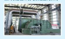
2023年8月11日,包钢股份余压余气节能减排CCPP发电项目5号燃机完成并网前所有实验,正式并入蒙西电网。该机组是包钢首套、国内第三套分轴式燃气——蒸汽联合循环发电机组,也是包钢同类型机组中首套热电联产机组。5号燃机首次采用分轴式布置,机组调节灵活性更高;作为典型的热电联产机组,单台机组最大蒸汽供应量达到200吨每小时,可同时满足公司生产用气和300万平方米市政采暖用气需求。
