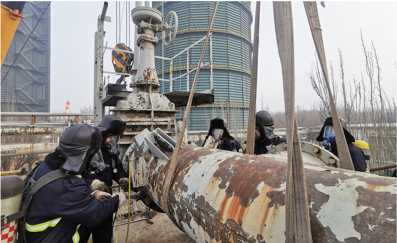
图为动供总厂职工正在进行供城市煤气出站主管道堵盲板作业。
