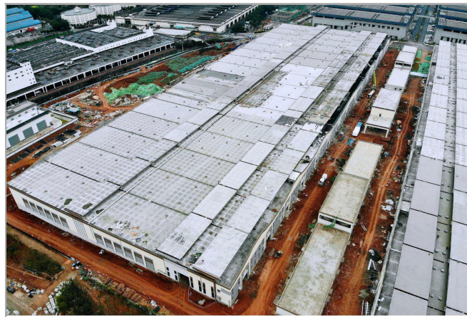
▲近日，由三公司承建的10万吨生态酿酒项目(一期)厂房及配套设施全面封顶。王冰 / 摄
