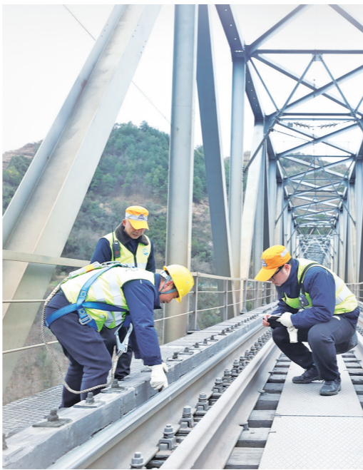
▲大学生示范队队员学习排查整治隧道病害。（张霖摄）
