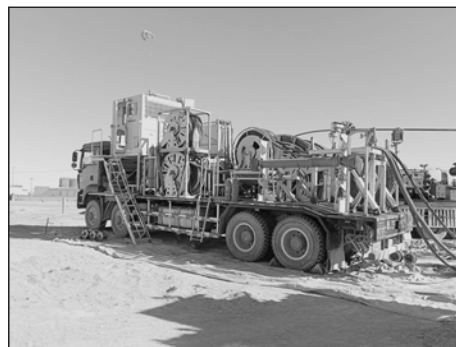
↑准东采油厂注水治理施工现场。
