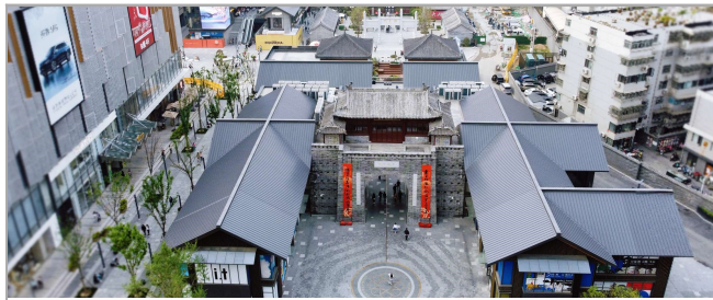
▲近日,由三公司承建的徐州文庙项目全面投入使用。
