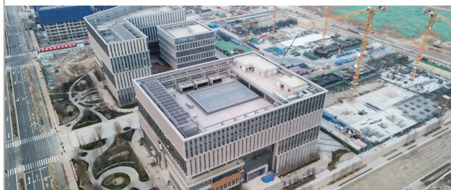
▲近日,由北方公司承建的雄安自贸试验区综合管理服务中心项目正式交付使用。
